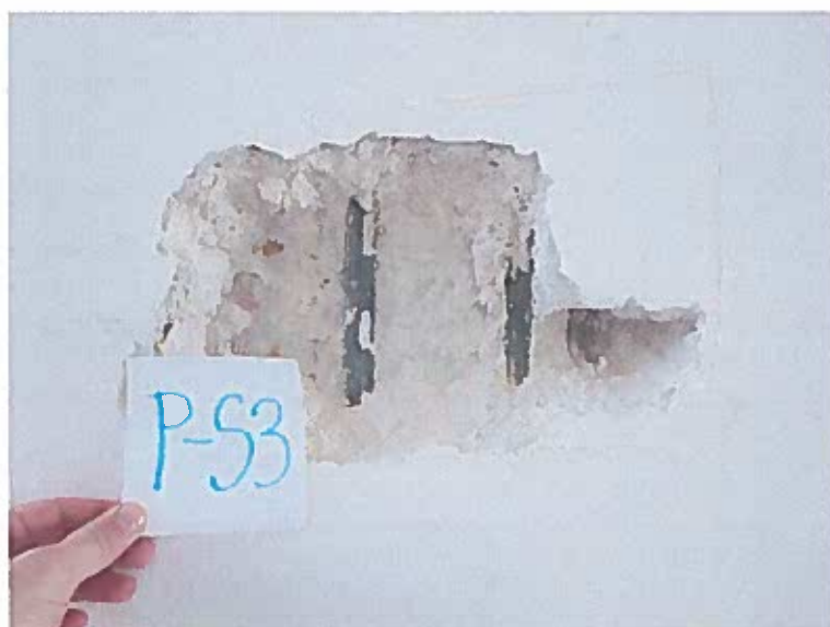
Slika 8: Preiskovalna sonda P-S3 na steni pritličja
