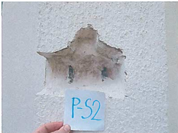
Slika 7: Preiskovalna sonda P-S2 na AB stebru pritličja
