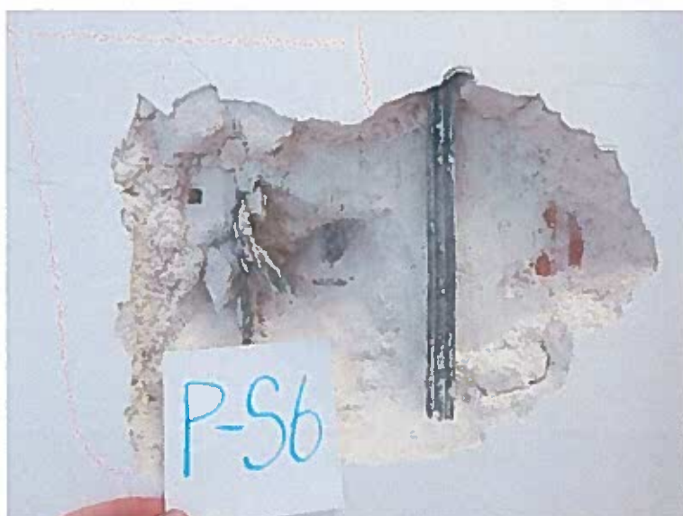
Slika 11: Preiskovalna sonda P-S6 na steni pritličja
