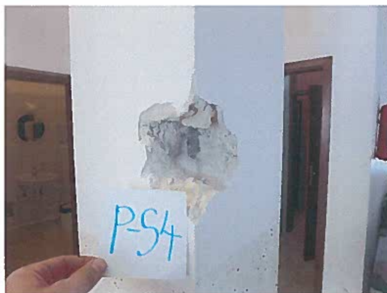
Slika 9: Preiskovalna sonda P-S4 na AB stebru pritličja
