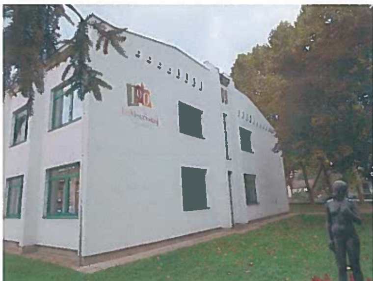
Slika 2: Glasbena šola Šoštanj, severozahodna fasada
