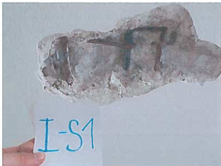
Slika 13: Preiskovalna sonda I-S1 na stropu I. nadstropja
