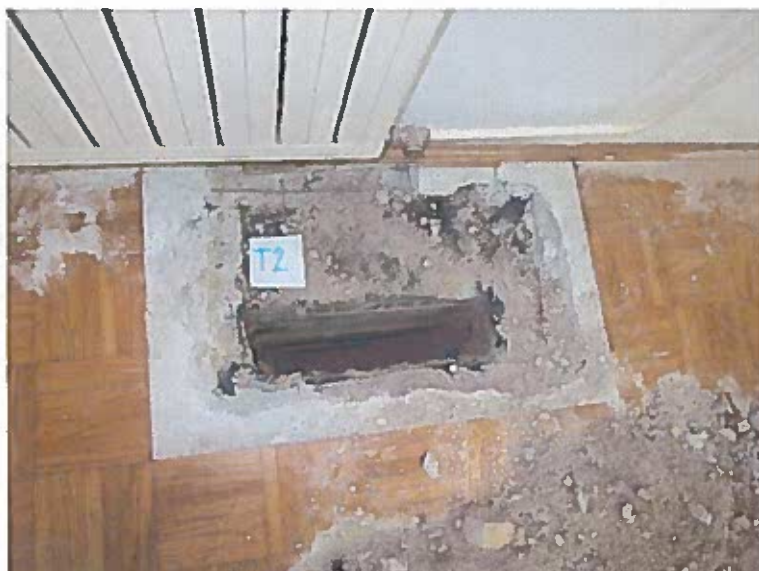
Slika 5: Sondažni izkop T2 ob temelju
