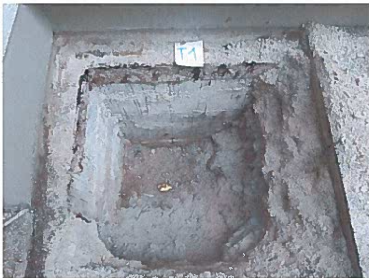
Slika 4: Sondažni izkop T1 ob temelju
