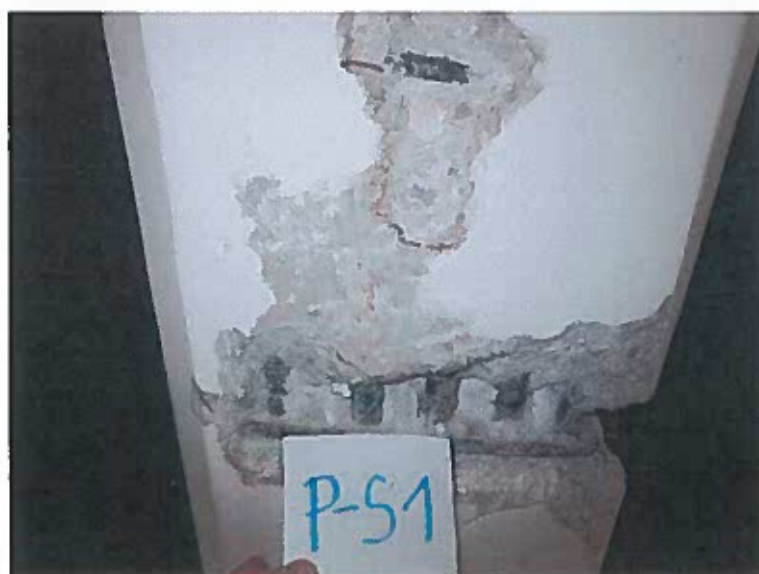
Slika 6: Preiskovalna sonda P-S1 na AB stropnem nosilcu pritličja
