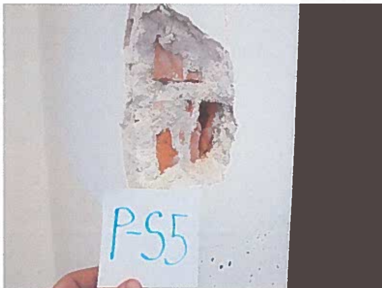
Slika 10: Preiskovalna sonda P-S5 na steni pritličja
